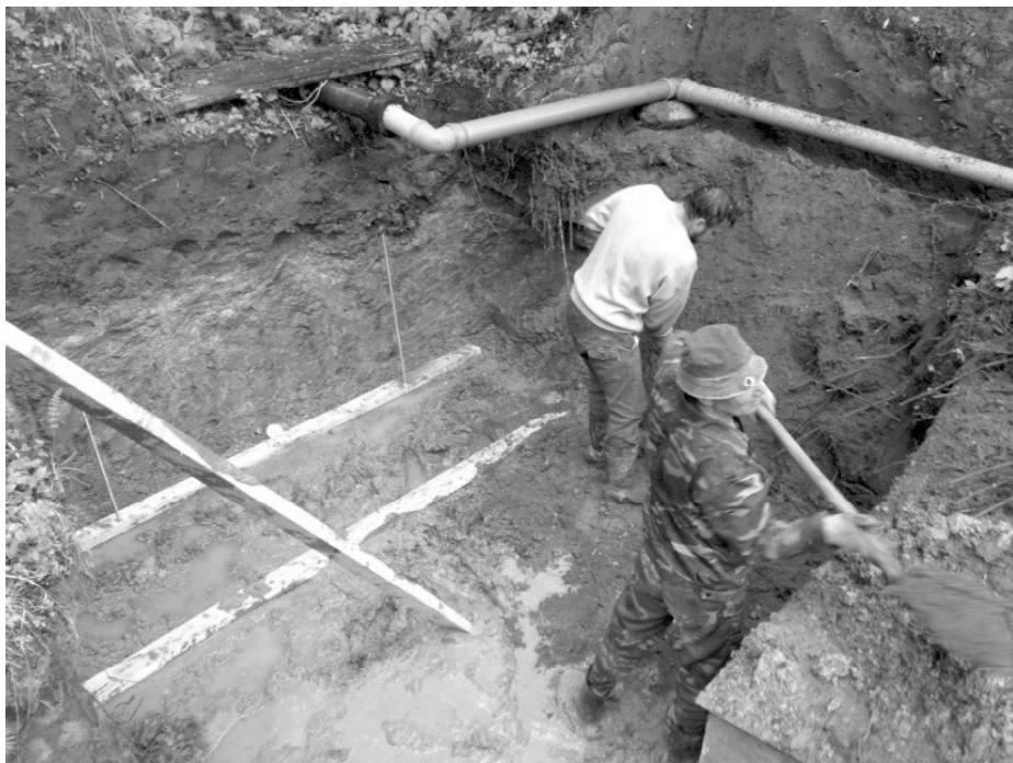
Самый трудоемкий этап строительства — рытье котлована.
