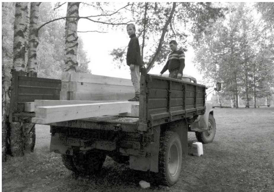
Юные помощники привезли брус.
